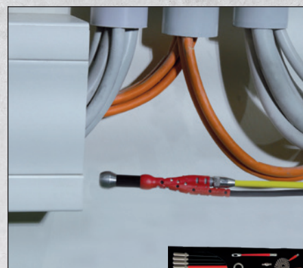
Šachty a kanály pod podlahou
